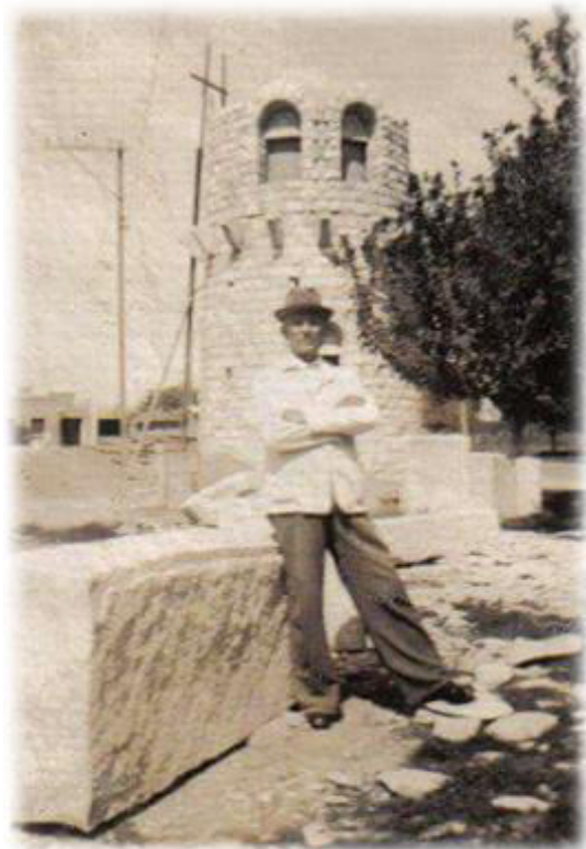
La obra se encontraba casi lista cuando El Sr. Eleuterio Castro posando para la cámara
